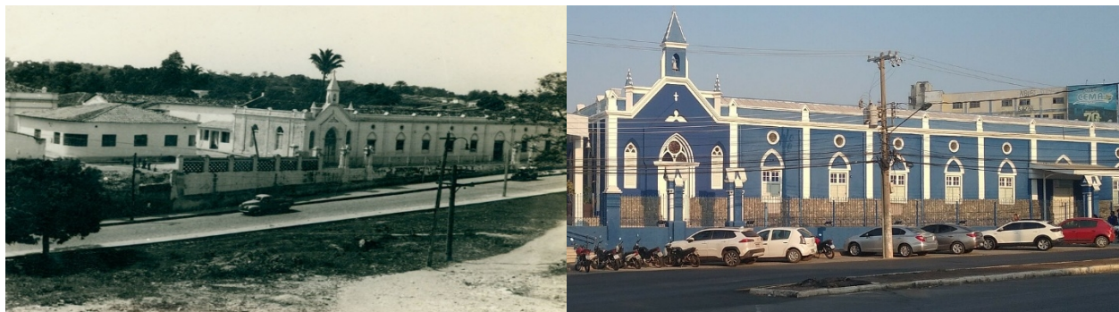
Foto 1 – Hospital Estadual Santa Casa - MT
